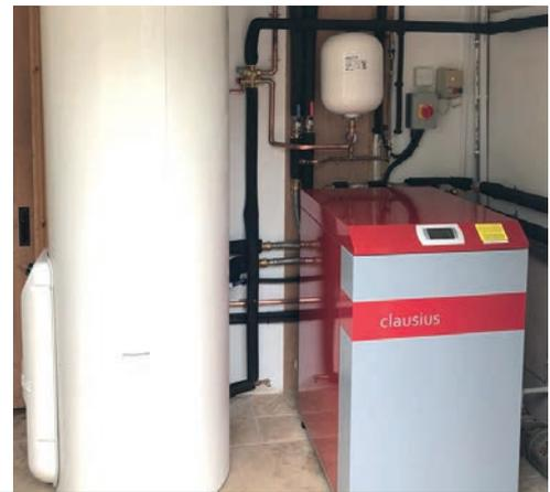
Warmwasserspeicher mit Desuperheater, 300 l
